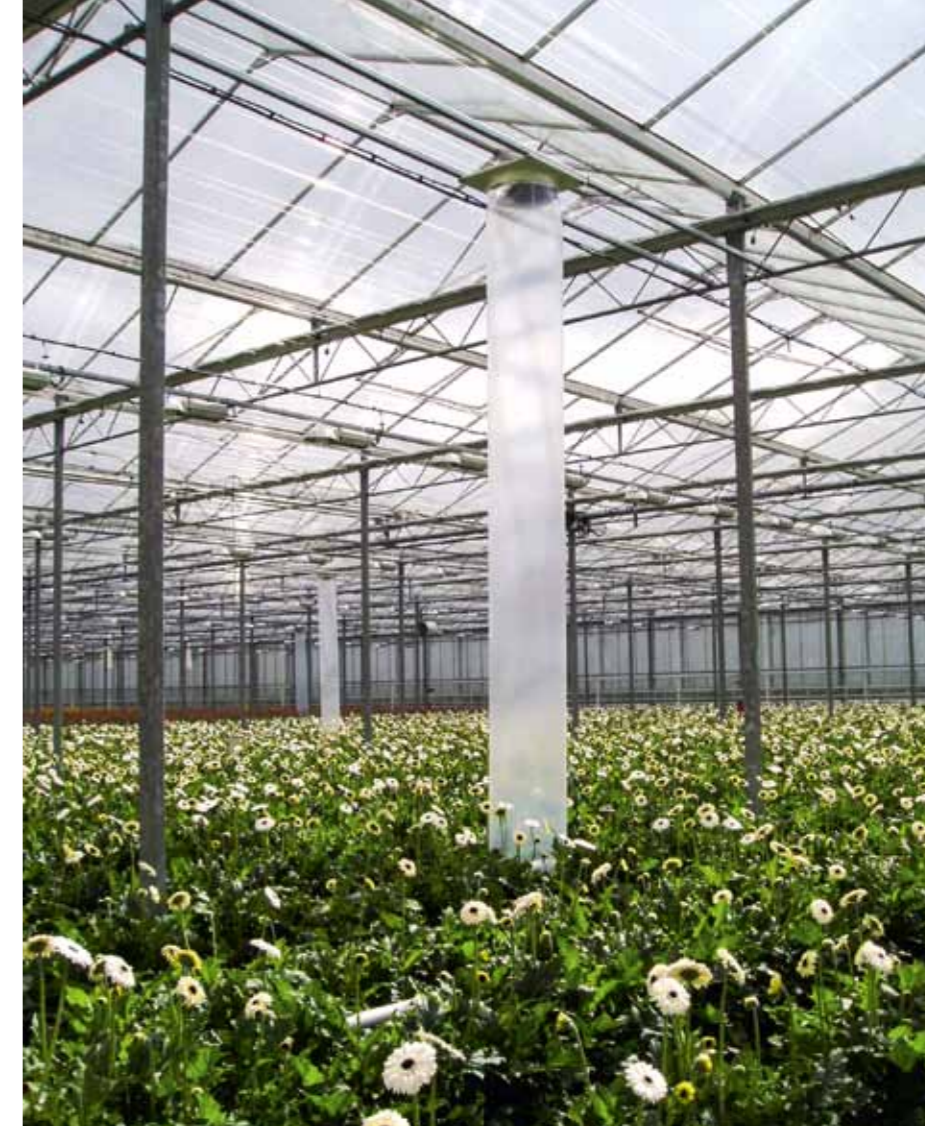
Het Verti-Fan-systeem bestaat uit een ventilator onder het schermdoek, die lucht door een transparante slurf naar beneden brengt.
