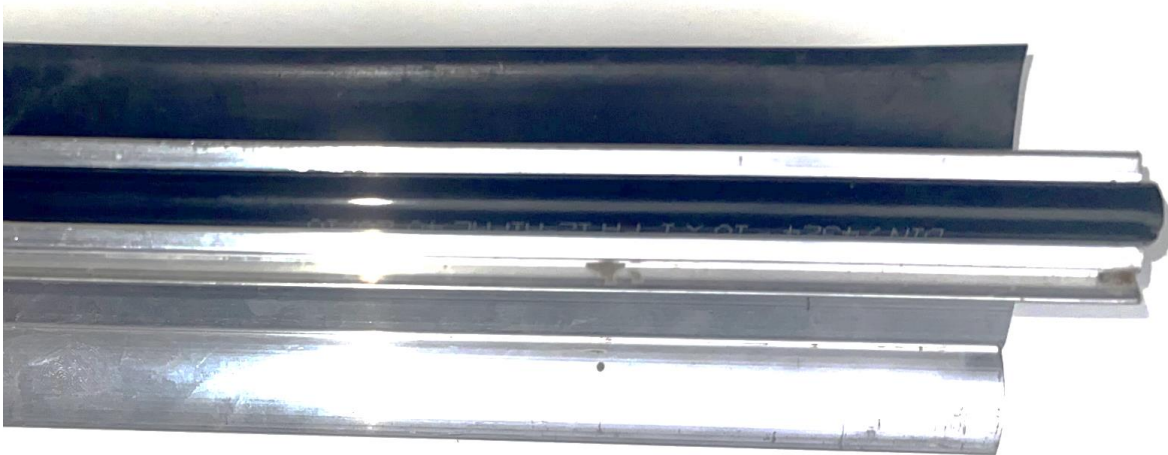
Figuur 21 Nylon slang ter bescherming van steundraden
