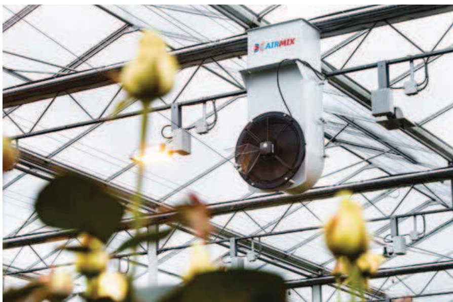
De horizontale ventilatoren zijn compact en werken ook als het scherm open ligt.
