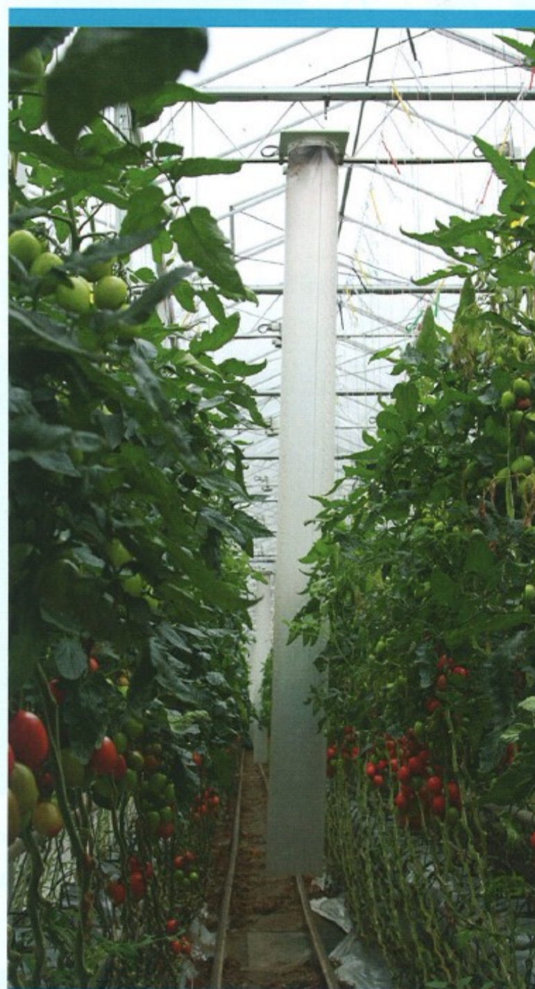
De Verti-Fan brengt warme lucht uit het bovenste deel van de kas via een transparante slurf omlaag, waar het onder de teeltgoten wordt uitgeblazen.
